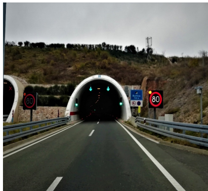
Slika 8. Semafori na ulazu u tunel
