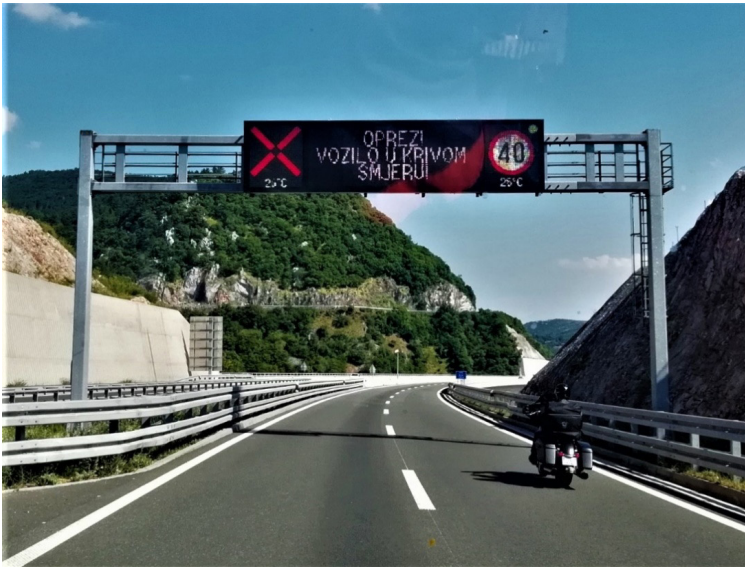
Slika 3. Primjer upravljanja promjenjivom prometnom signalizacijom na autocesti
